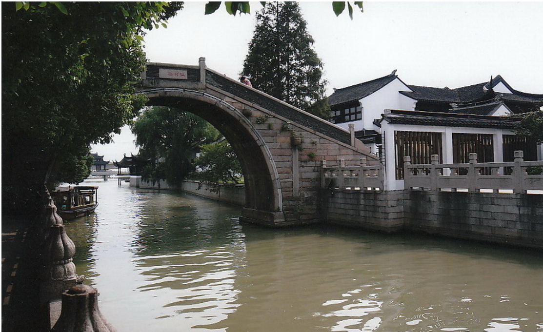
烏鎮拱型石橋
